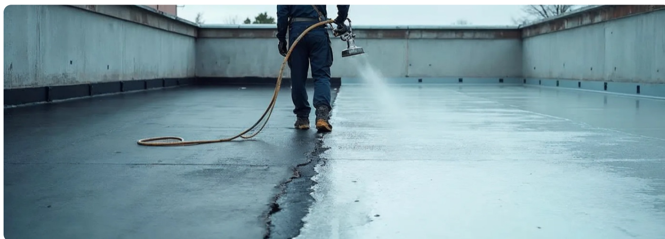
Nahtlos statt Bahnenstoß: Die Flüssigabdichtung umschließt Attika, Durchdringungen und Aufbauten ohne Formteile.
