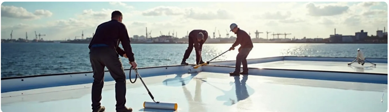
Unser Team beim Auftrag der Flüssigabdichtung auf einem Flachdach an der Ostseeküste — ruhige, saubere Baustelle ohne Abriss.
