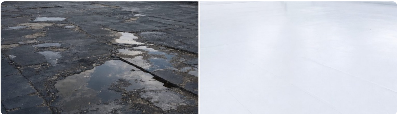
Vorher / Nachher: Ein klassisches Bitumendach mit Rissen und stehender Nässe (links) und dieselbe Fläche nach der Sanierung mit Flüssigkunststoff-Abdichtung (rechts).
